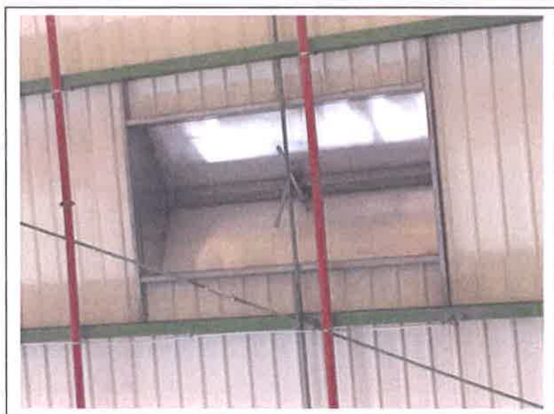
Répartition des exutoires au niveau d'une cellule
