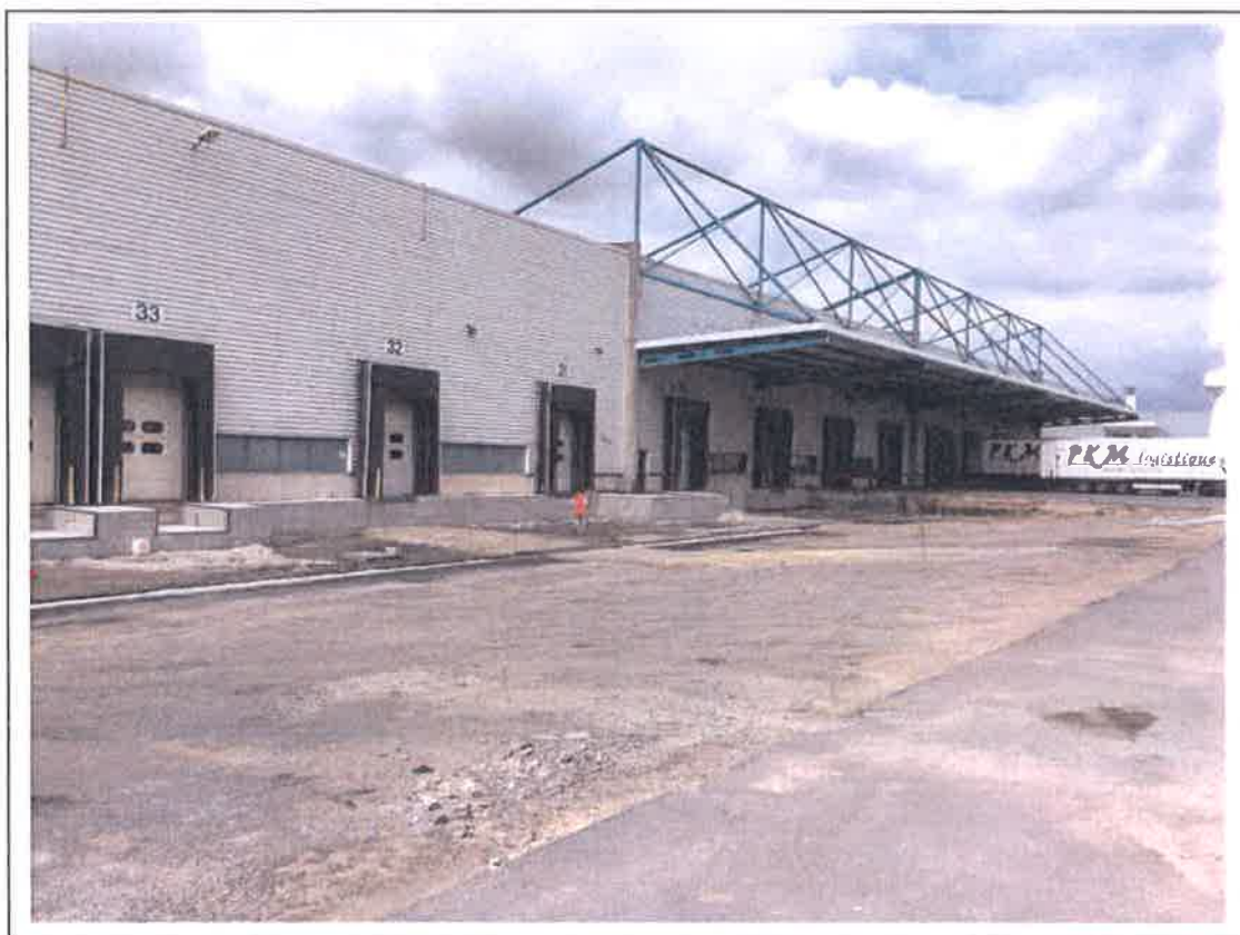
Façade côté quai de chargement
