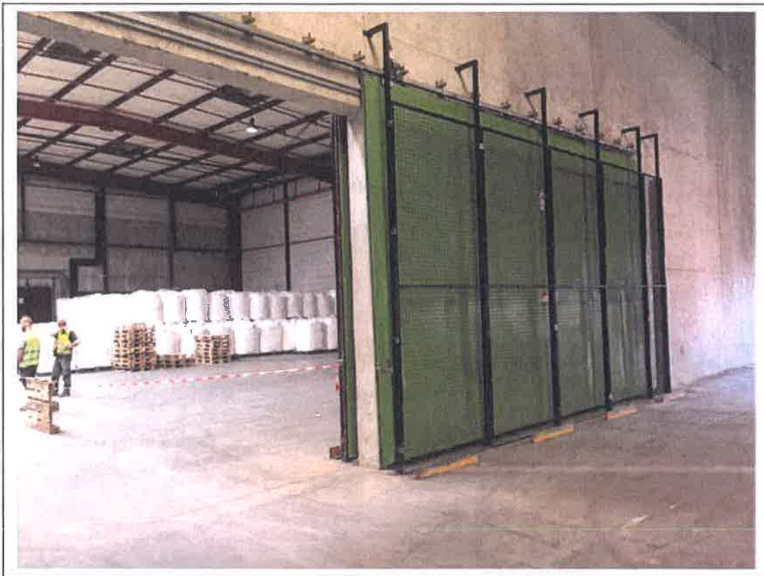
Paroi séparative entre 2 cellules + portes coulissantes assurant l'isolement
