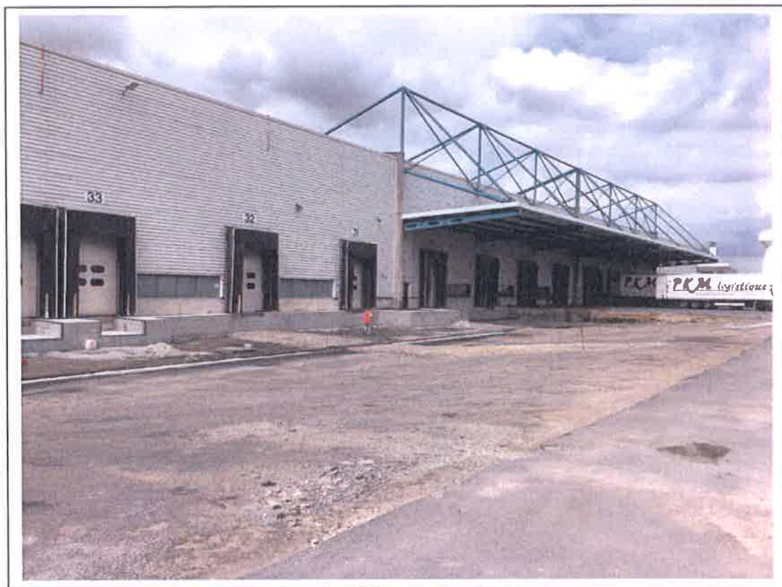
Façade côté quai de chargement
