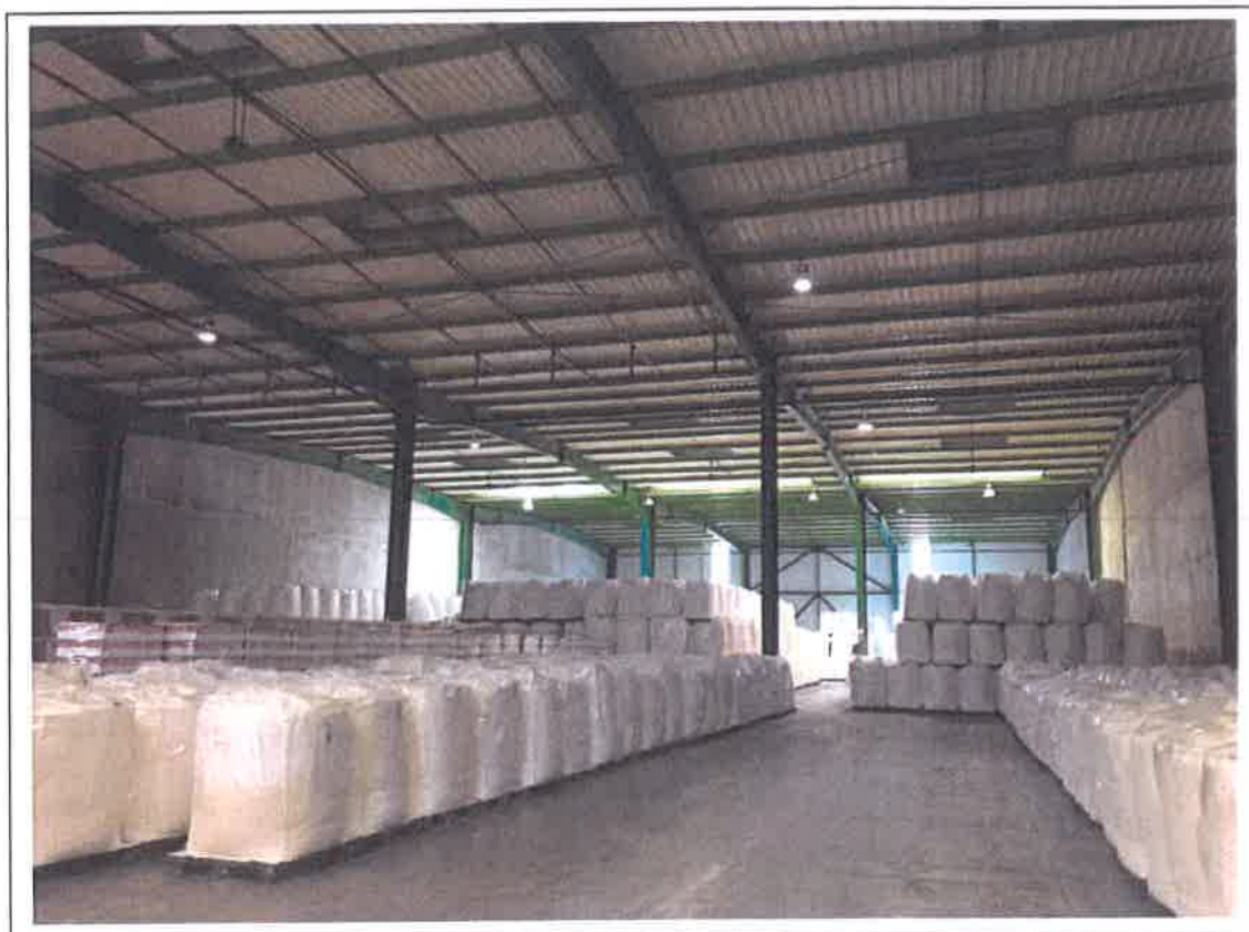
Structure d'une cellule – charpente métallique Sous face de la couverture en bac acier
