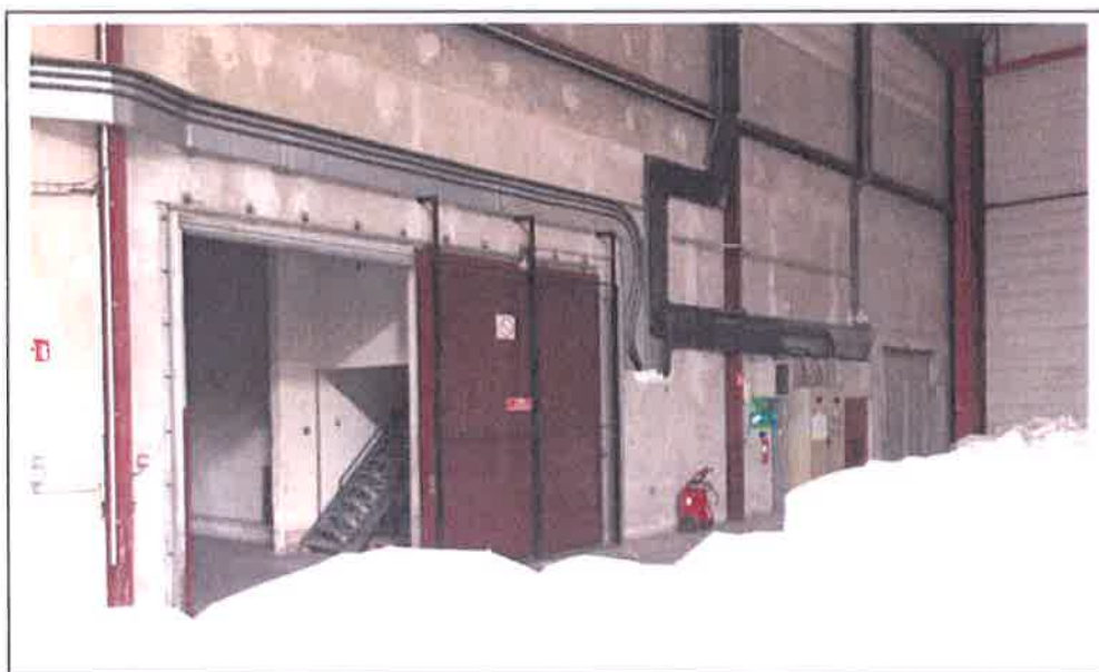
Paroi séparative entre la zone bureau et la première cellule
