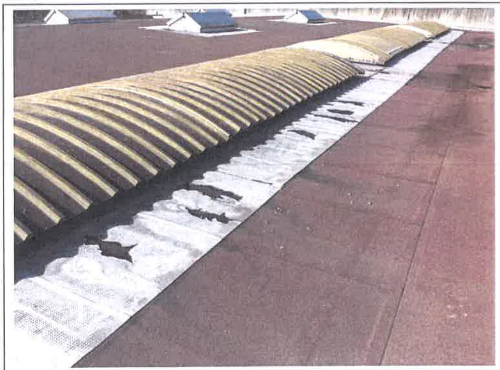
Puits de lumière disposés en couverture
